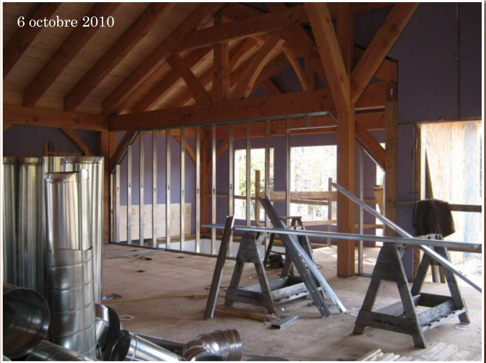
Vue sur l'ascenseur et le portique
