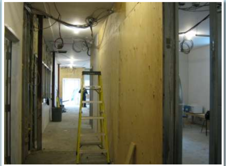
Salle multi-service à droite Salle de Fartage à gauche
